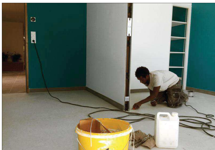
Sols, peintures et ameublement sont en cours dans la maison de santé.
